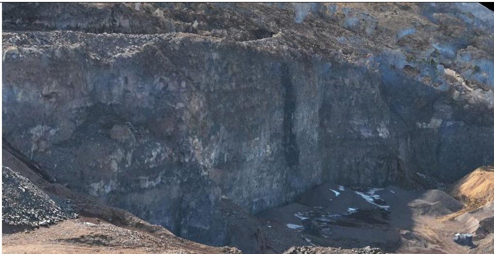
图 3-1 矿山部分边坡照片
